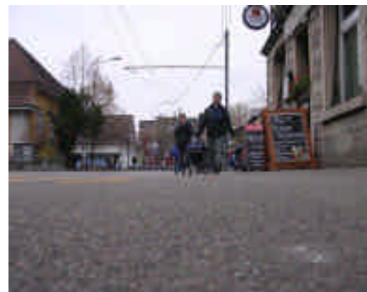
Abb. 39 Trottoir ohne Seitenneigung
