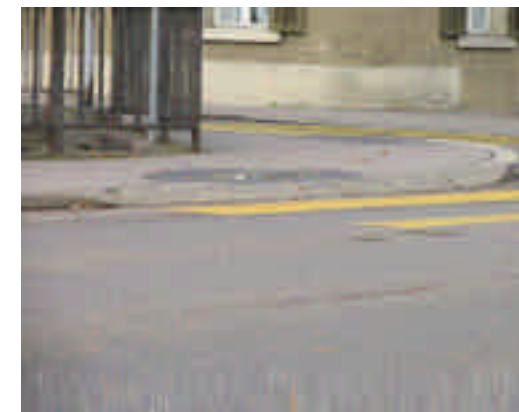
Abb. 72 Trottoirkante auf der Brücke
